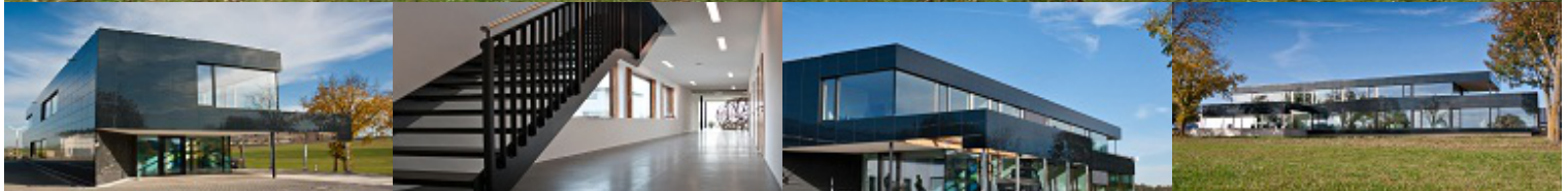
Neubau eines Verwaltungsgebäudes in Amerdingen
