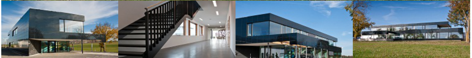
Neubau eines Verwaltungsgebäudes in Amerdingen
